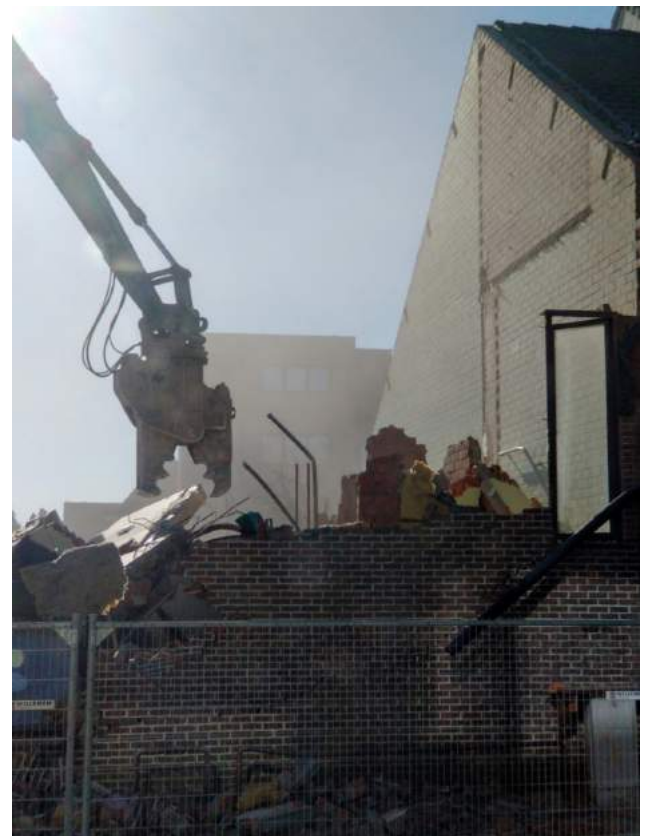
Het sloopmonster zet zijn tanden ook in het gebouw van de ziekenkas..
